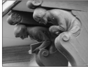
Les consoles en bois de la Villa Trübner.
